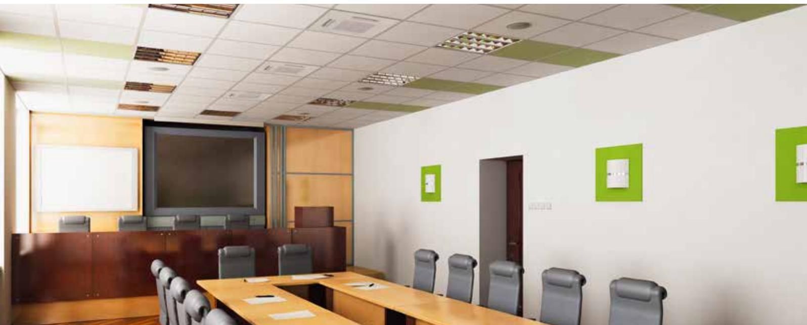
Кассетные внутренние блоки RCIM Mini с раздачей воздуха по 4-м направлениям отличаются низким уровнем шума и имеют множество особенностей конструкции, облегчающих монтаж: регулируемая высота крепления, компактная конструкция, низкая масса и стандартизированные размеры лицевой панели.
