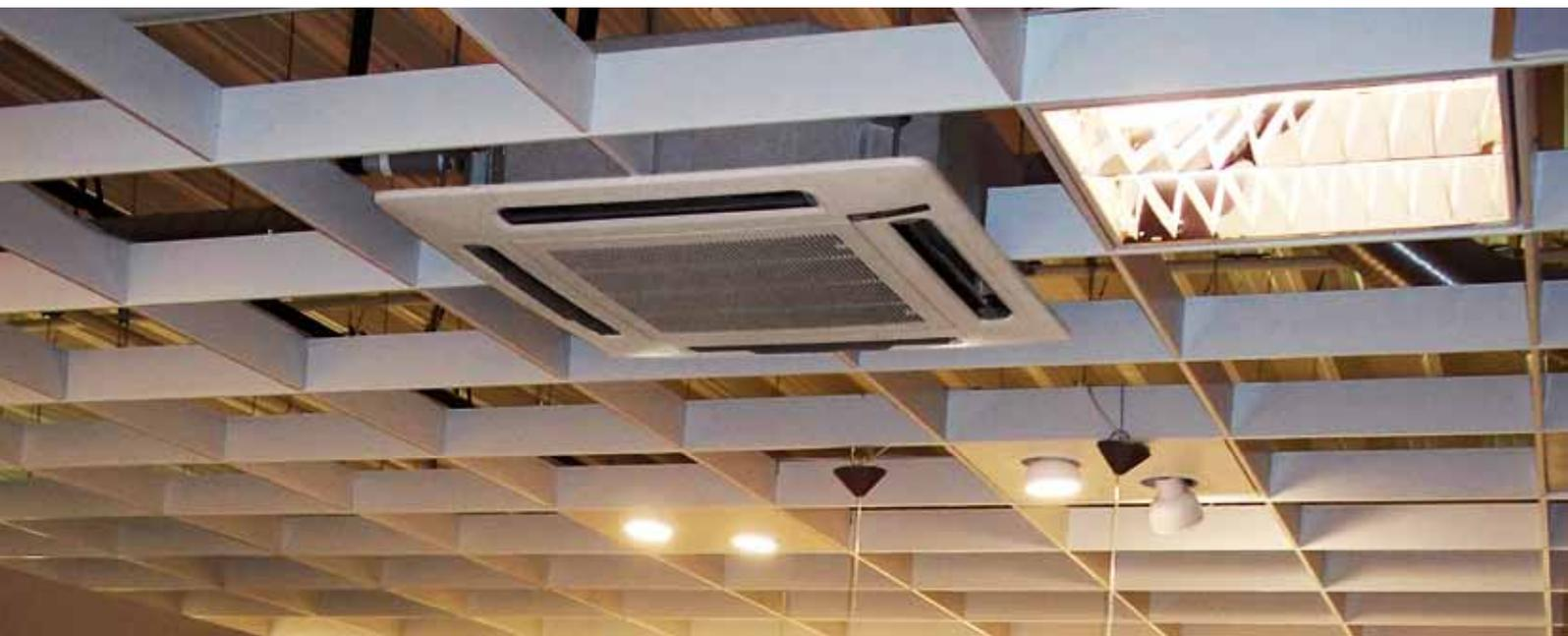
Кассетные блоки RCI с раздачей по 4-м направлениям отличаются особо низким уровнем шума и компактностью. Регулируемая высота крепления, уменьшенная на 50 %, по сравнению с предыдущими моделями, масса и стандартизированные размеры лицевой панели обеспечивают простоту монтажа и подсоединения агрегатов.
