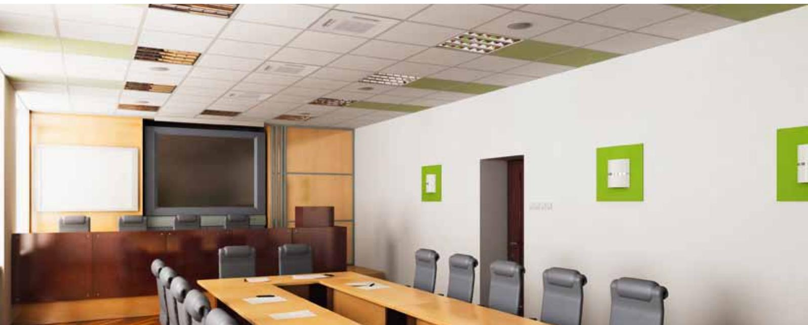
Кассетные внутренние блоки RCIM Mini с раздачей воздуха по 4-м направлениям отличаются низким уровнем шума и имеют множество особенностей конструкции, облегчающих монтаж: регулируемая высота крепления, компактная конструкция, низкая масса и стандартизированные размеры лицевой панели. Благодаря стандартизированным положениям при монтаже облегчается подсоединение трубопроводов.
